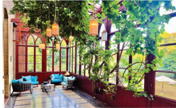
Baudenkmal "Schloss Düneck" in Moorrege Aufarbeitung der Fensterrahmen und Holzelemente der Veranda
