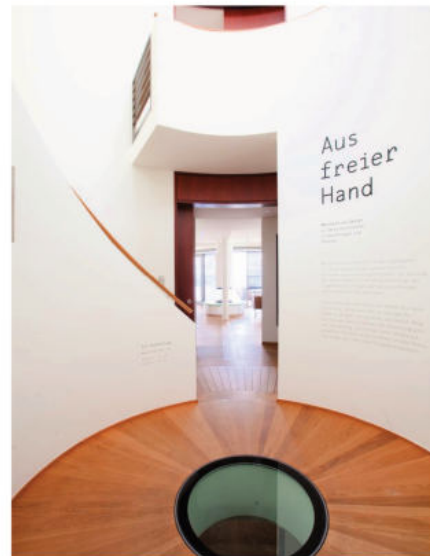
Villa an der Elbchaussee Geschwungener Treppenaufgang mit biegbaren Gipskartonelementen
