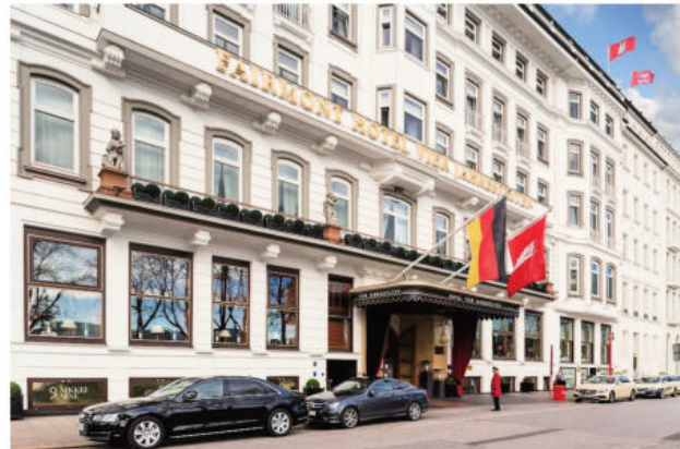
Fairmont Hotel Vier Jahreszeiten Hamburg Fassadenrenovierung
