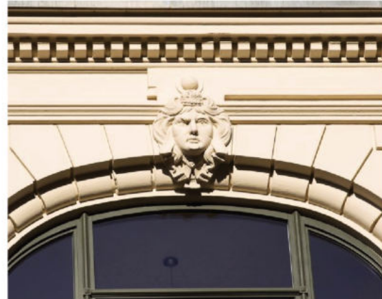
Kontorhaus am Hopfensack Sanierung der historischen Fassade
