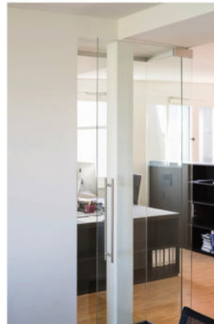
Dachausbau in Harvestehude Einbau von Glaselementen und -türen
