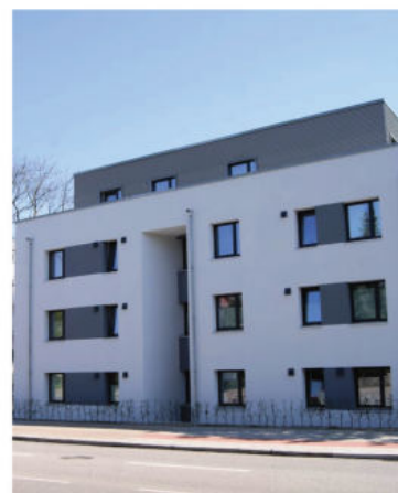
Mehrfamilienhäuser in Fuhlsbüttel Ca. 3.000 m 2 Dämmstoffe (Polysterol, Mineral- wolle und Phenolharz)
