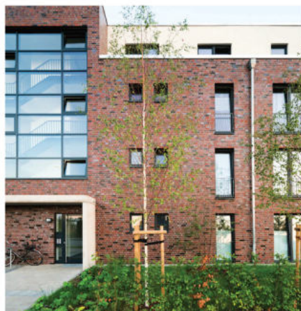
Neubau einer öffentlich geförderten Wohnanlage mit 128 Wohneinheiten Fassadendämmung mit Klinkerriemchen
