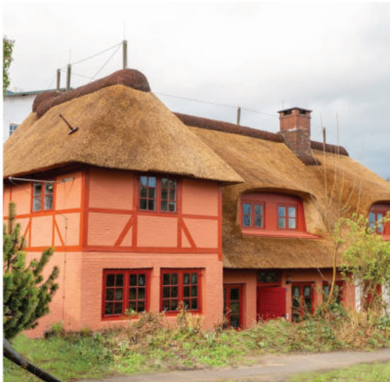
Altes Fischerhaus in Blankenese, erbaut um 1570 Geschlämmte Fassade: Durch diese Maßnahme verhindert man das Eindringen von Feuchtigkeit in das historische Mauerwerk.
