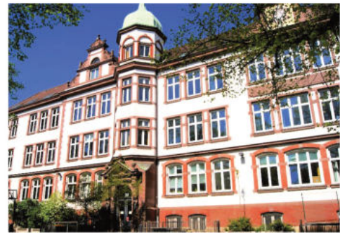
Brecht-Schule Hamburg Sanierung der rückseitigen Fassade sowie der Giebel
