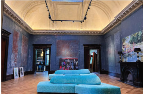
Baudenkmal "Schloss Düneck" in Moorrege Freilegung und Rekonstruktion historischer Wandflächen
