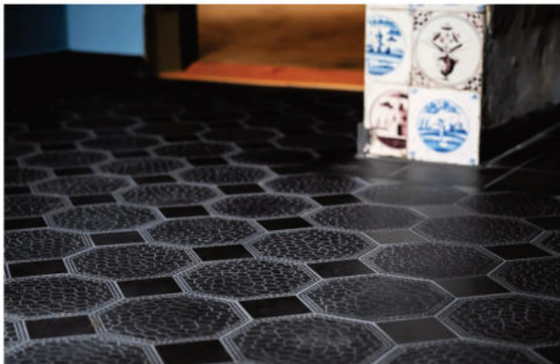
Das denkmalgeschützte „Fischerhaus“ in Blankenese Erneuerung der Bodenfliesen nach historischem Vorbild
