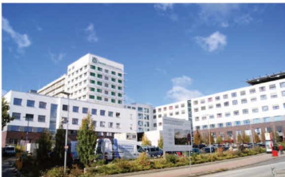
Asklepios Klinik Harburg Ca. 3.500 m 2 Mineralwollendämmung mit Putzoberfläche, ca. 600 m 2 Mineral- wollendämmung mit keramischer Belegung
