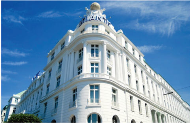
Hotel Atlantic Kempinski Hamburg Fassadensanierung: Reparatur und Erneuerung schadhafter Gesimssteine, Lackierarbeiten an Fensterrahmen, Baldachinen und Fallrohren, Fassadenanstrich
