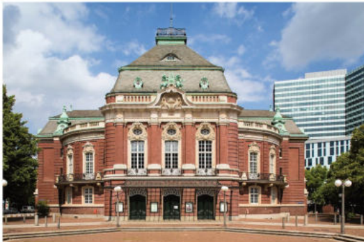
Laeishalle Hamburg Grundsanierung an ca. 450 m 2 Holzfenstern: vollständiges Entfernen des Altanstrichs und Beschichtung der Rahmen mit einem Leinöllacksystem entsprechend der Vorgaben des Denkmalschutzamtes
